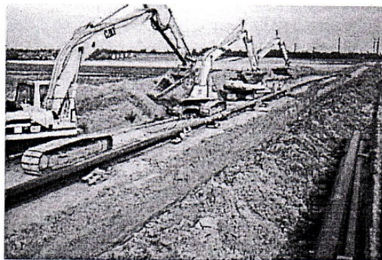
Röhreinbringung in den Leitungsgraben westlich von Köln
