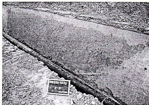
Materialentnahmegrube in der Wand des Leitungsgrabens
