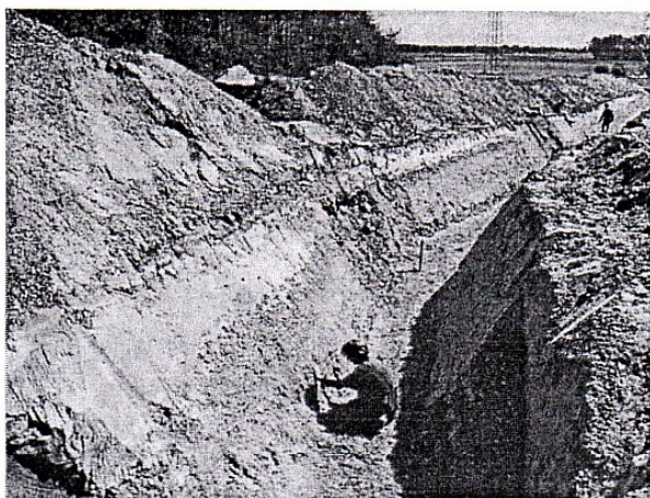
Dokumentation der frischen Grabenprofile in der ausgehobenen Pipelinetrasse
